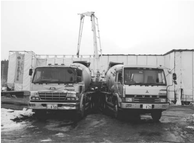
図-14 雪囲いによる寒中コンクリートの施工状況
