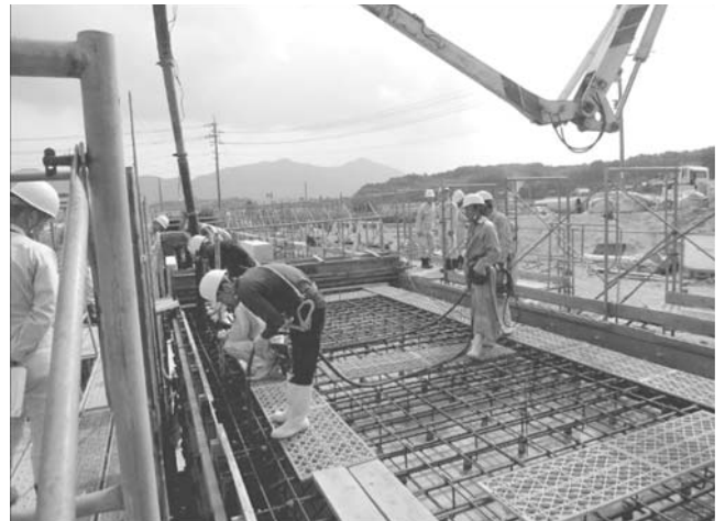
図-5 締固め作業を行う作業員
