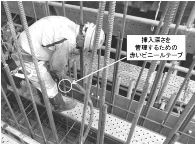
図-6 ビニールテープによりバイブレータの挿入深さを管理する作業員
