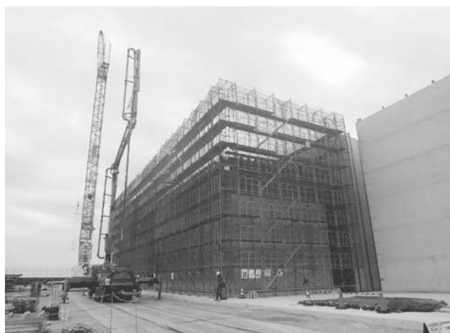
図-12 横浜市のケーソン製作現場
