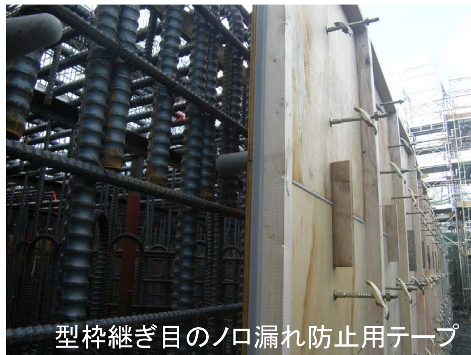
型枠継ぎ目のノロ漏れ防止用テープ
