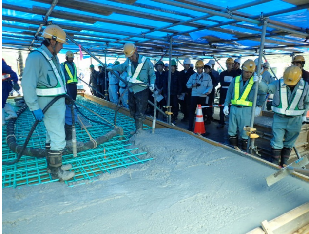
① 打込み班（筒先パイプ）
